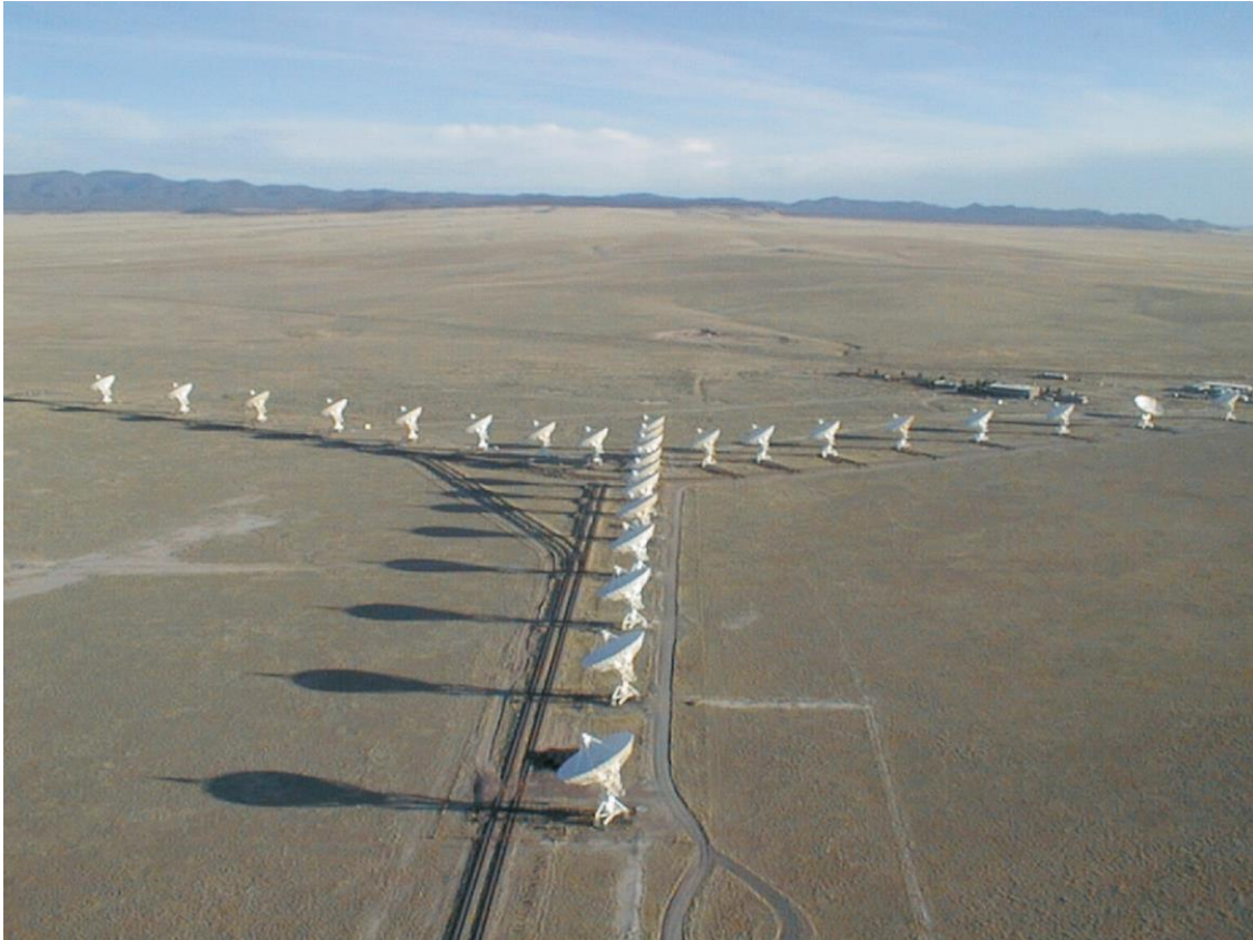
Figura 4. Interferómetro Very Large Array, VLA, en Nuevo México, Estados Unidos, que cuenta con 27 antenas colocadas en una forma de Y. Crédito: NRAO/AUI/NSF.
