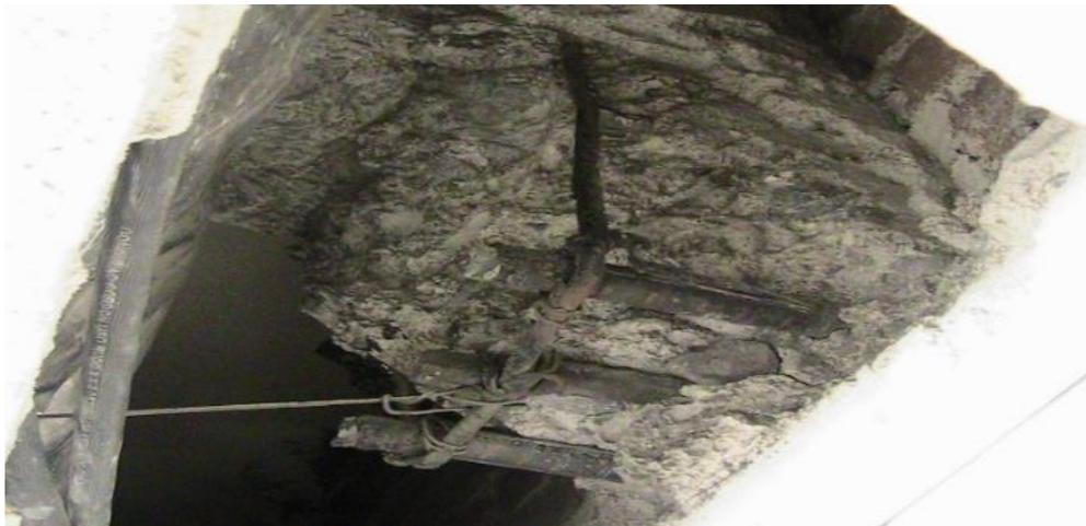
**Figura 7. Concreto y acero de refuerzo de trabe principal de entrepiso totalmente destruidos. Fuente, archivo personal (2012)**
