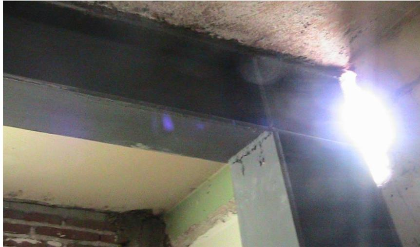
**Figura 10. Relleno de mortero expansivo y acabados anticorrosivos. Fuente, archivo personal (2012)**
