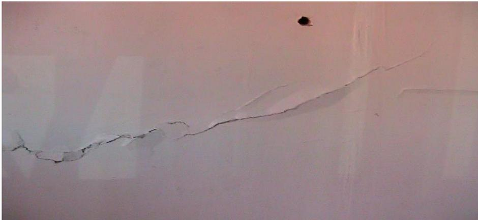
**Figura 11. Expulsión de rellenos en grietas por recuperación de deformaciones. Fuente, archivo personal (2012)**
