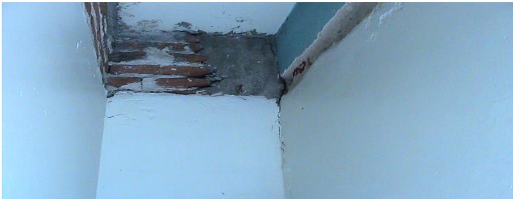
**Figura 5. Muro agrietado, ya resanado. Fuente, archivo personal (2012)**
