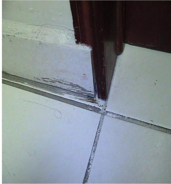
**Figura 4. Zoclos desfasados y resanados en el entrapiso del segundo nivel. Fuente, archivo personal (2012).**
