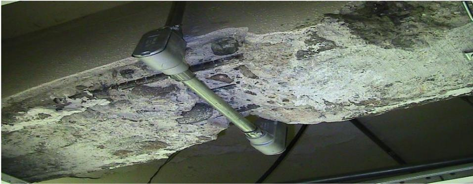
**Figura 6. Concreto destruido en trabe cargadora de entrepiso para dar paso a ducto de instalaciones eléctricas. Fuente, archivo personal (2012)**
