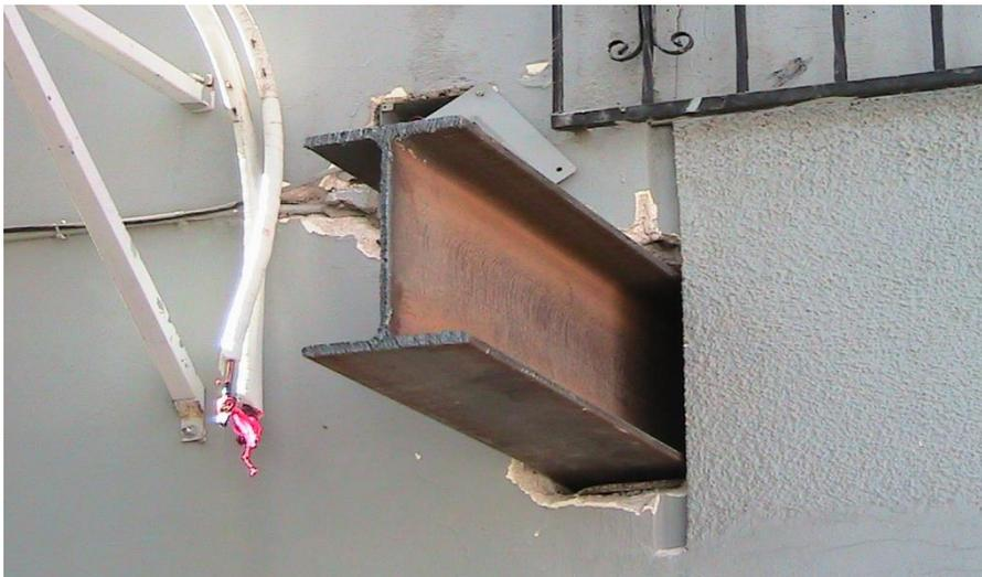
**Figura 9. Inserción y montaje de viga metálica para reestructuración. Fuente, archivo personal (2012)**
