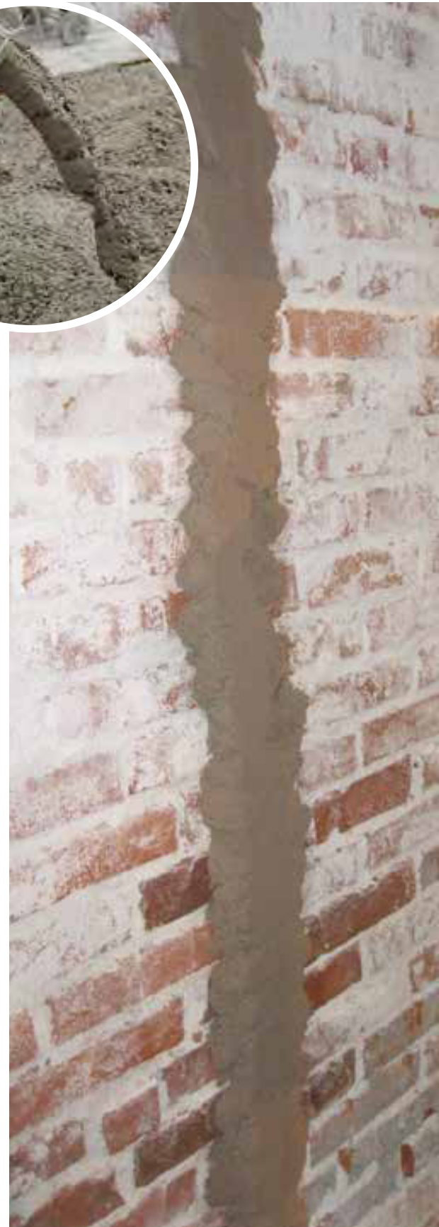
Figura 1. Mezcla de los materiales aligerados con perlita sintética
