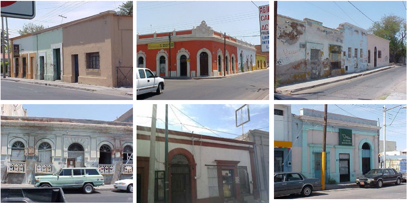
Ilustración 18 y 19. Vivienda demolida en un “Sabadozo”, aun cuando el INAH, les había informado que estaba incluida en la Declaratoria de patrimonio edificado. Fotos propiedad de Luis Antonio Urías de la Vega.
