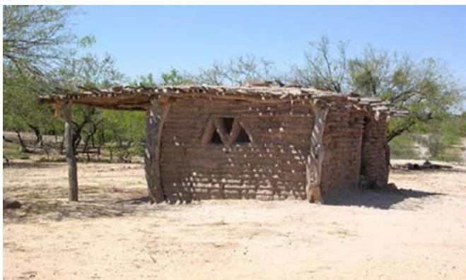
Fig. 4.- Estructura de horcón, viga de madera (tronco), morrillos y cama de corazón de pitahaya, para recibir terrado. (construcción en Masiaca, Sonora). Prop. De Carlos V. Tostado C. 2004.
