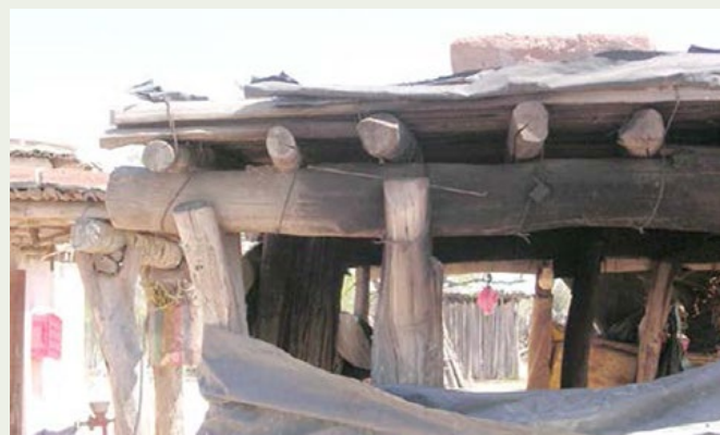
Figura 5.- Vivienda mestiza en Choacalle, Sonora, mostrando la estructura de horcones, vigas y morrillos, cubiertos sus muros con adobe y ramada cubierta de tierra. Prop. De Carlos V. Tostado C. 2004.
