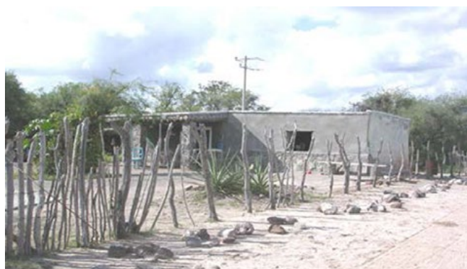
Figuras 7y 8.- La vivienda mestiza con muros de adobe y terrado en techumbre, es emplazada, muchas veces, a corta distancia de la calle y con escasa vegetación. En la construcción se observa una ventana de dimensiones mínimas y orientación hacia el poniente, en tanto el ingreso principal se posiciona hacia el sur para aprovechar los vientos dominantes en verano.
