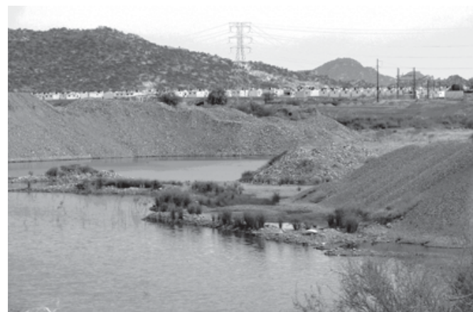
Banco de materiales inundadas con aguas residuales pegado a una unidad habitacional
