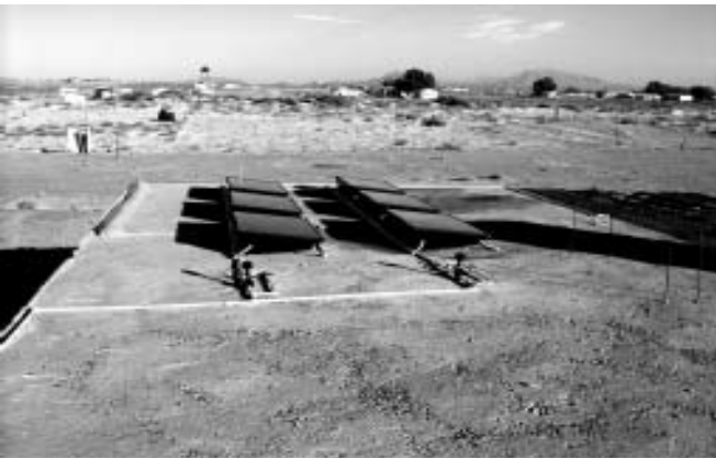
Figura 9. Destiladores solares sobre la antigua planta frigorífica
