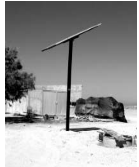
Figura 4. Pozo de agua de mar
