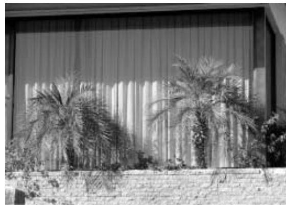
3 FIGURA S 2 Y 3. Residencias en Hermosillo; cada vez se recurre con mayor frecuencia a ventanas "selladas" que no permiten abrirse, por lo tanto se elimina la posibilidad de ventilación natural
