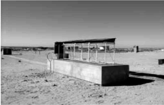
Figura 7. Instalaciones de los destiladores solares ubicados en la escuela primaria
