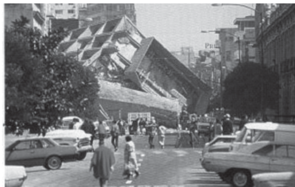
Figura 4. Derrumbe de edificios debido al sismo del 19 de Septiembre de 1985 en la ciudad de México 3
