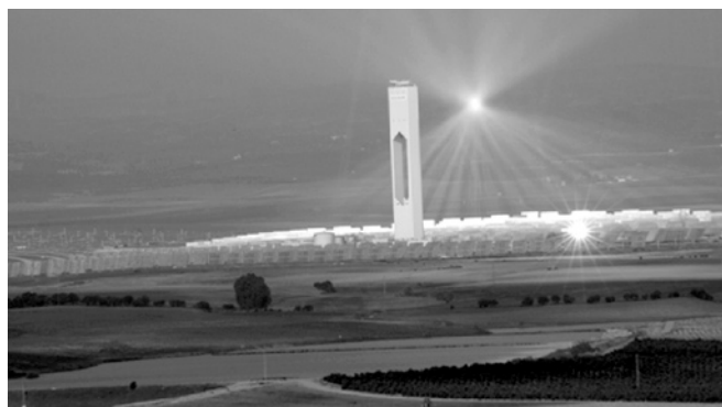
Figura 9. Planta Solar de Torre Central en Salúnkar la Mayor, España.
