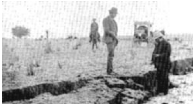
Grietas producidas por el temblor de 1887
