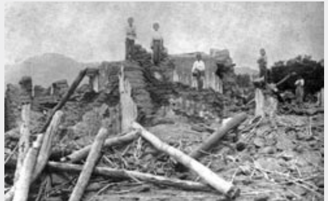
Destrucción producida por el temblor de 1877 en Bavisp
