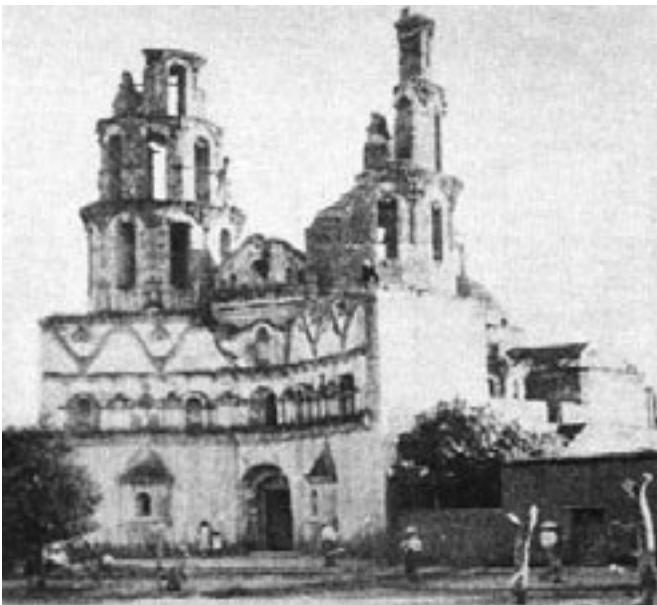
Iglesia de Bacadéhuachi después del temblor de 1887
