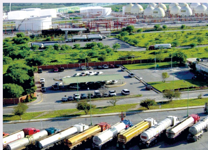
Figura 10. Centro de Procesado de Gas Burgos en el estado de Tamaulipas [7].
